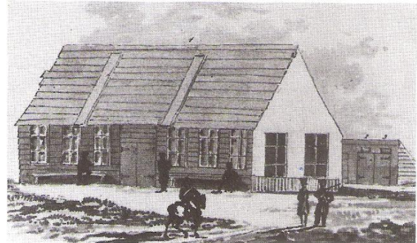
Cantine van de officieren; rechts enkele latrines.
